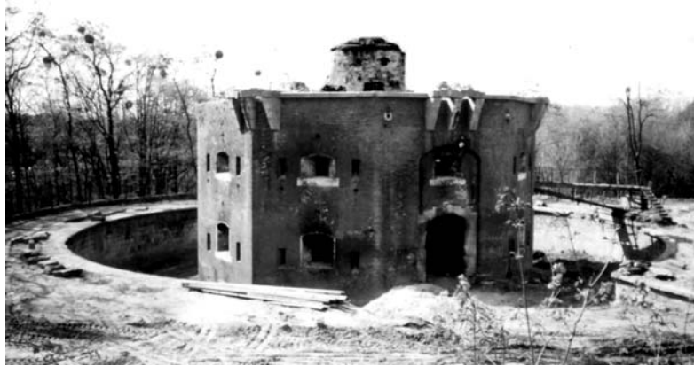
Рис. 6. Південно-західна вежа. Стан по руйнації земляного валу – брустверу (фотофіксація І.В. Оконченка станом на 10.05.2001 р.)
