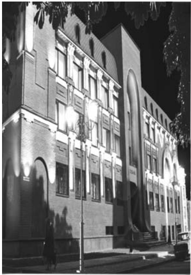
Рис. 3. Будинок культури (Рівне). Варіант контурного освітлення за рахунок контрасту кольору між поверхнями та нішами. Досягнуто ефект зорової трансформації глибини простору
