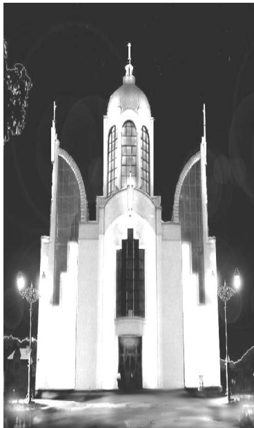
Рис 2. Церква (Чортків) Світлова композиція підкреслює об'єм церкви та виділяє центральний вхід, купол та кутові хрести. Досягнуто ефекту ілюзорної зміни масивності архітектурних форм
