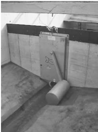
Рис. 6. Регулятор витрати Hydroslide
