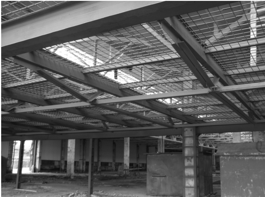
Малоелементні комбіновані ферми перекриття з регулюванням зусиль L=12 м. Бізнес-центр “Підзамче”, (м. Львів, 2007 р.)
