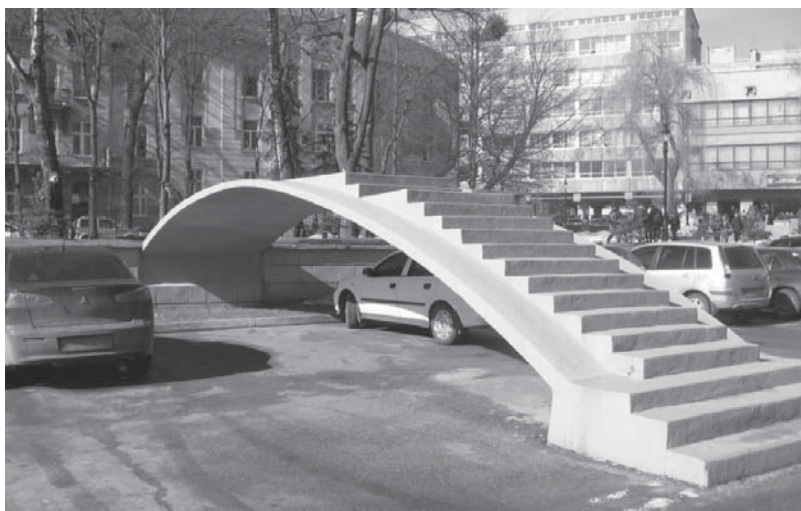
Рис. 10. Сучасний вигляд моста після ремонту
