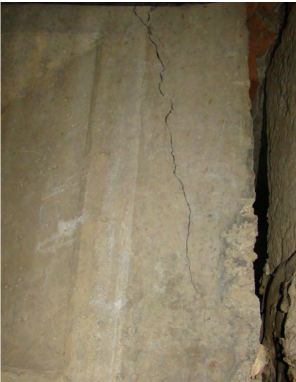
Рис. 1 Руйнування балок покриття з виникненням аварійних тріщин та сколюванням бетону
