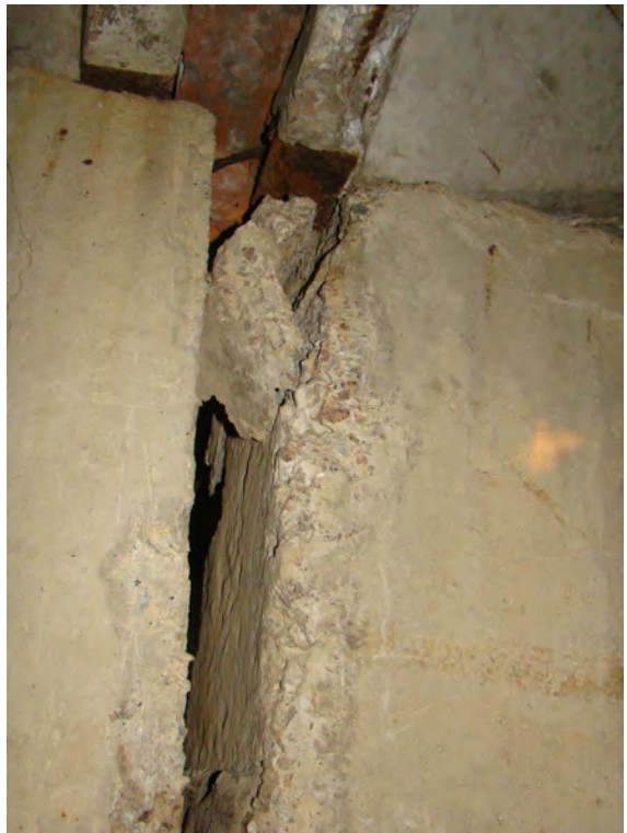
Рис. 1 Руйнування балок покриття з виникненням аварійних тріщин та сколюванням бетону
