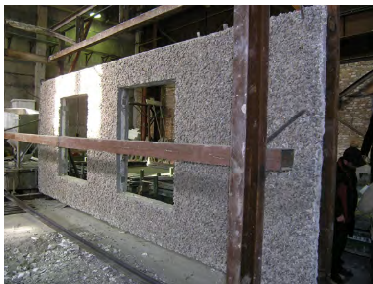
Рис. 2. Общий вид трехслойной стеновой панели
