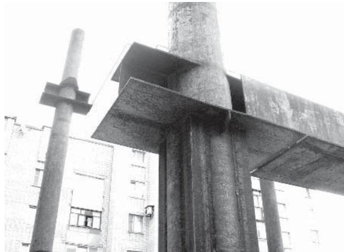
Рис. 1. Вузол примикання сталезалізобетонного ригеля до трубобетонної колони під час монтажу
