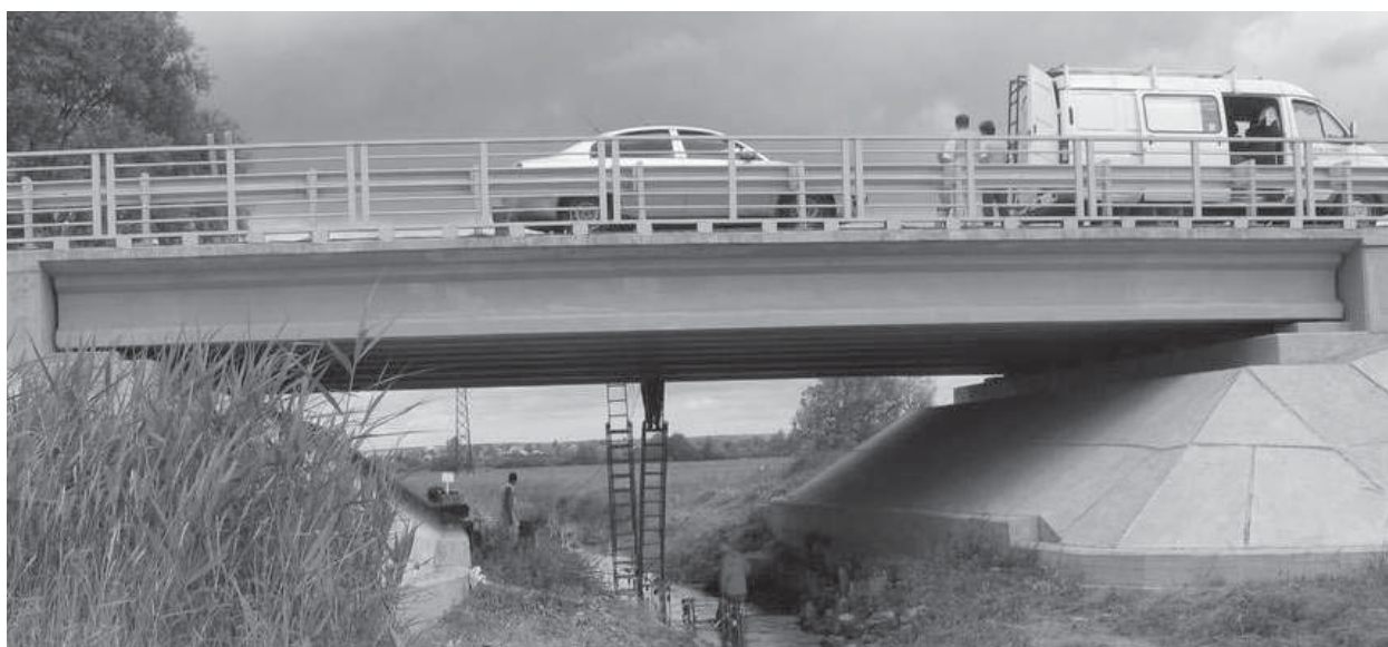
Рис. 1. Загальний вигляд моста через струмок на а/д Н-13, км 57+206
