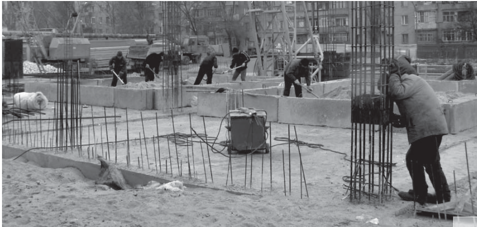
Рис. 5. Нагружение плоского сборно-монолитного перекрытия в процессе испытания
