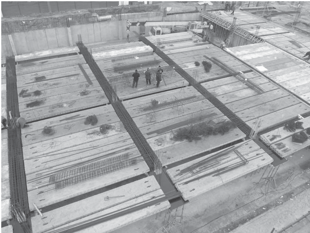
Рис. 1. Фрагмент сборно-монолитного перекрытия в процессе монтажа
