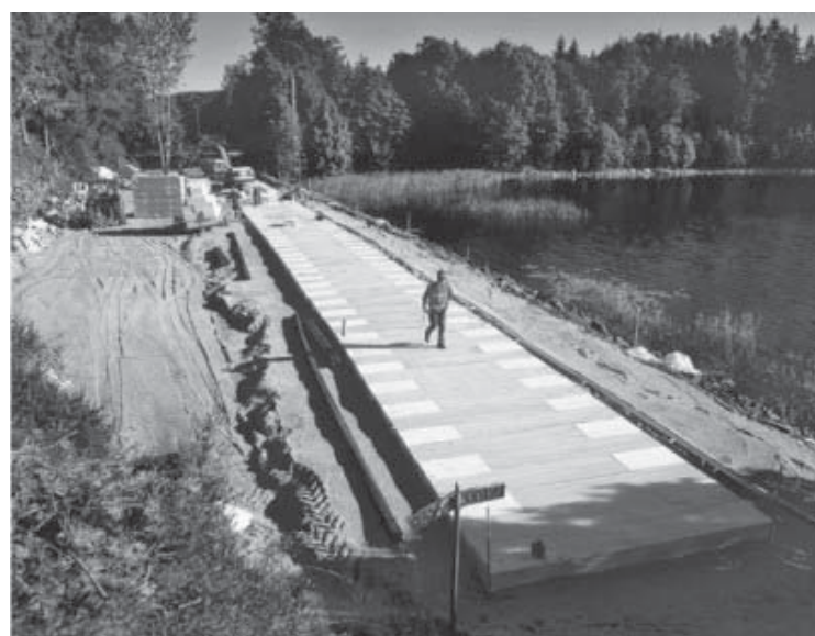
Рис. 2. Влаштування теплоізоляційного шару дороги в Бельгії
