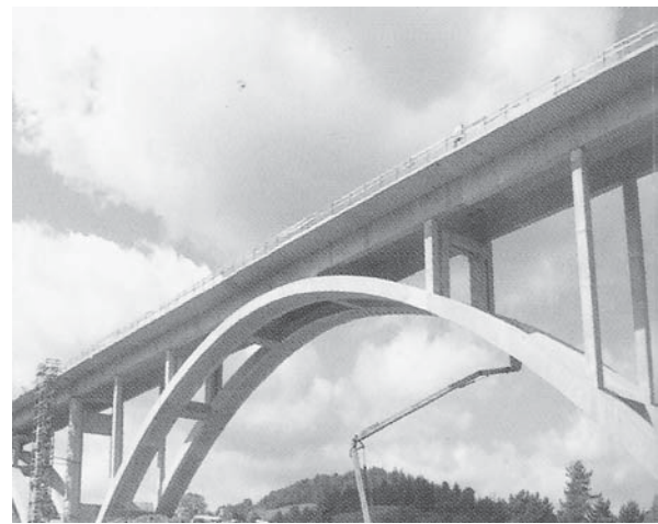
Рис. 6, 7. Комбіновані металеві і залізобетонні конструкції з різним розміщенням балки жорсткості, Німеччина
