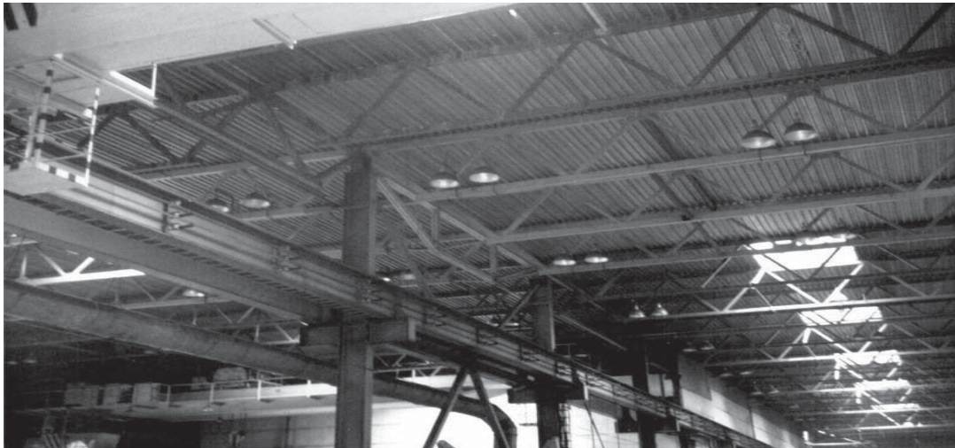
Рис. 12. Підкрюквяна балкоферма L=12 м. Завод експериментальних механічних випробувань, м. Львів, 2004 р.
