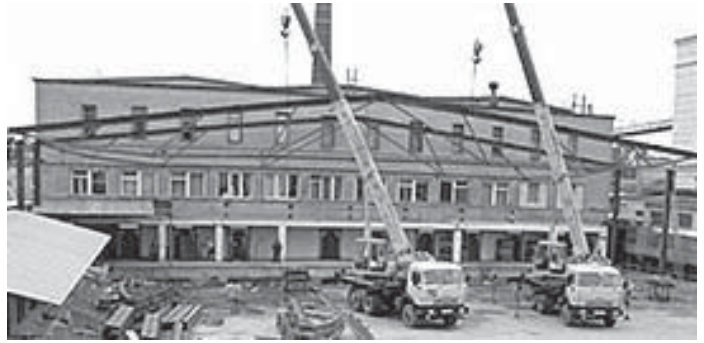
Рис. 9. Монтаж комбінованої ферми, Росія
