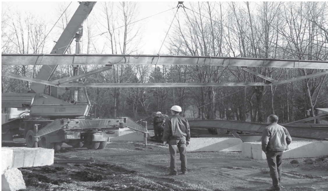
Рис. 10. Монтаж малоелементної шпрингельної ферми прольотом L=12 м. Санаторій "Женева", м. Трускавець, 2004 р.
