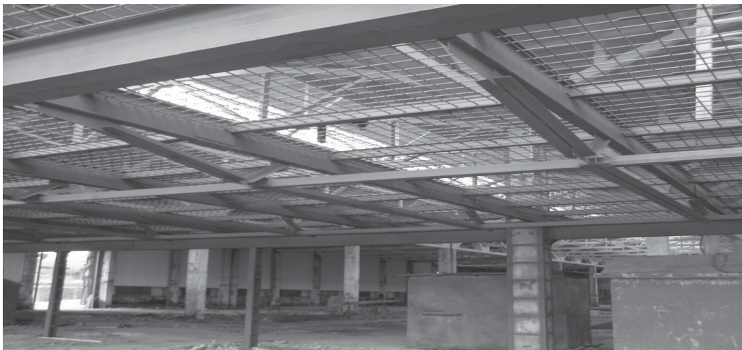
Рис. 11. Малоелементні комбіновані ферми перекриття з регулюванням зусиль L=12 м. Бізнес-центр "Підзамче", м. Львів, 2007 р.
