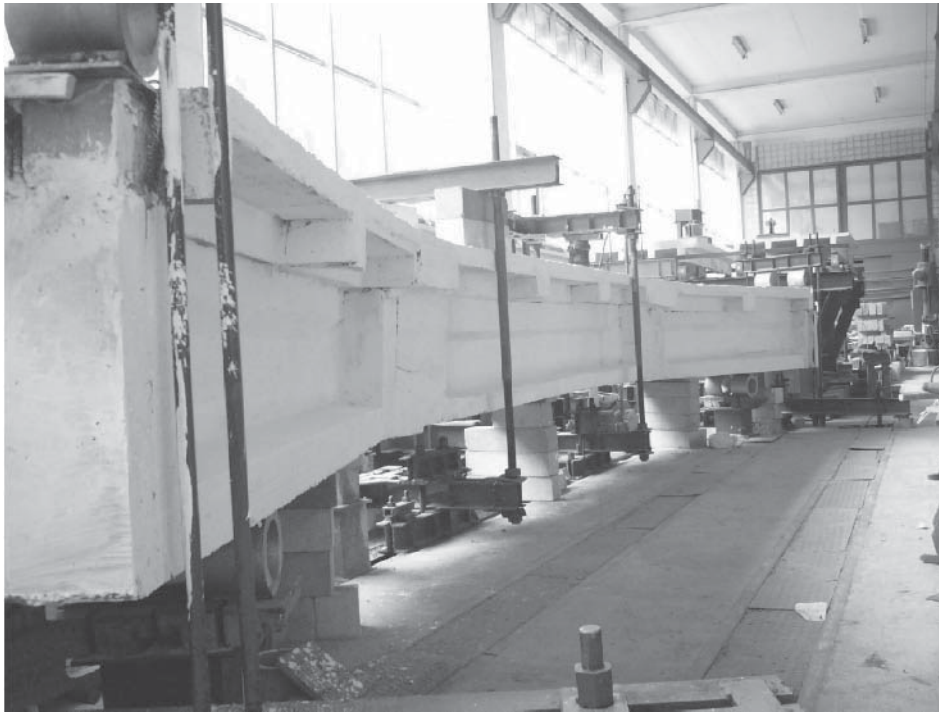
Рис. 8. Загальний вигляд дослідної конструкції прогонової будови естакади на кривій на випробувальному стенді
