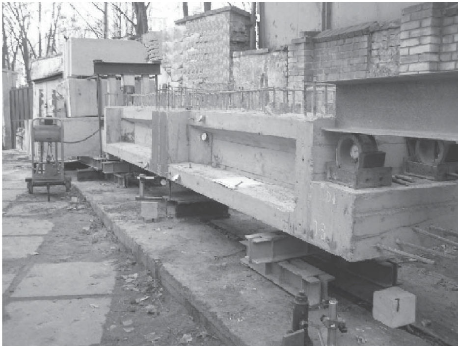
Рис. 7. Загальний вигляд досліджуваної конструкції балки монолітної ділянки, підготованої до випробувань на стенді
