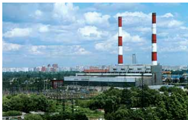
ТЕЦ-5. м. Київ, вул. Промислова, 4
