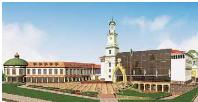
Реконструкція незавершеного будівництва під навчальний корпус Національного університету «Острозька академія»
