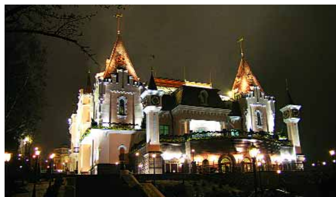
Освітлення лялькового театру в м. Київ, виконане СП «Ватра-Шредер»
