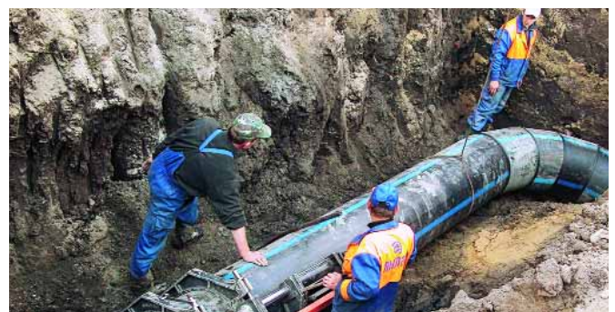
Будівництво напірного водогону ведуть фахівці компанії «Ельпласт»
