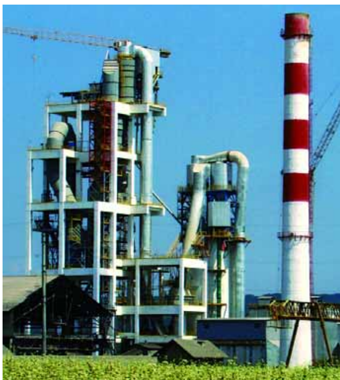
Декарбонізатор з циклонними теплообмінниками і силосом сировинної муки
