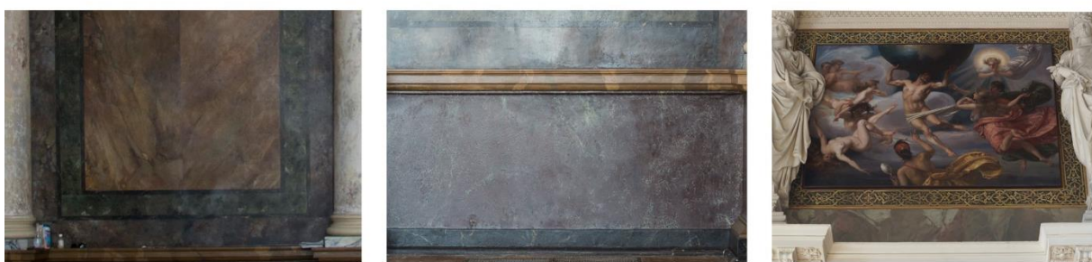
Рисунок 5.3.41. – 5.3.43. Вигляд елементів після завершення усіх реставраційних етапів.
