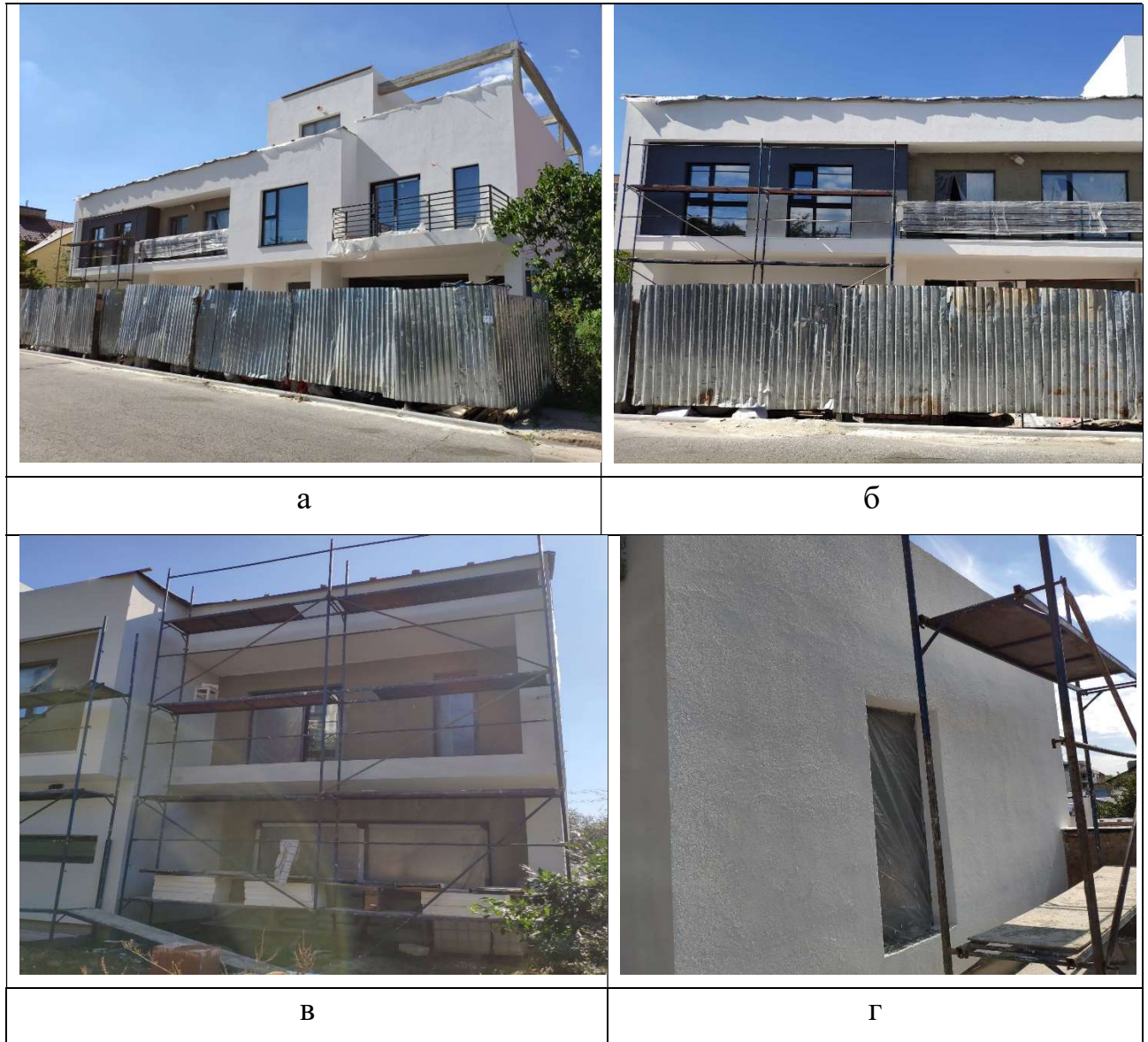
Рисунок 5.6 – Триквартирний житловий будинок в м. Львові по вул. Балтійська 6 під час проведення оздоблення фасаду з використанням наномодифікованого фотокаталітичного оздоблювального розчину
