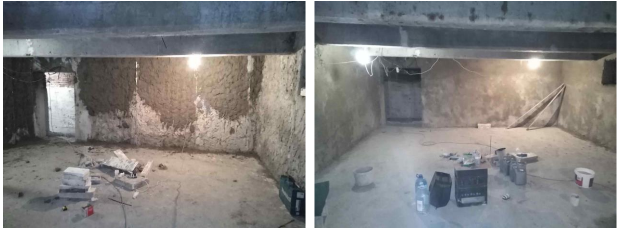
Рисунок 5.4 – Нанесення гідроізоляційної безусадочної ремонтної суміші з гідрофобною добавкою при виконанні гідроізоляції підвального приміщення офісного центру
