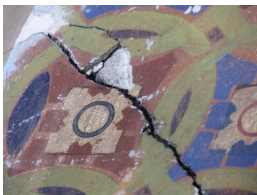
Рис. 4.6 Макрофотофіксація: деструкція тиньків, верств поліхромії, зміна авторської колористики (фото: Дуткевич та Радомська, 2007)
