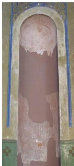
Рис. 4.8 Церква Арх.Михаїла, с.Підберізці. Північна ніша трансепту в процесі реставрації: а – розкриття автентичного стінопису, б – колористично-рисуноква реконструкція; в – після реставрації (фото: Дуткевич та Радомська, 2008)
