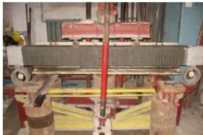
Рис. 2.17. Нанесення з'єднувального шару по поверхні «старого» бетону
