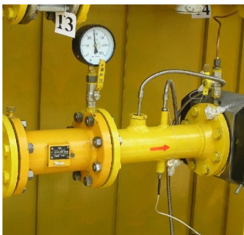
Рис.3.29. Вузол обліку природного газу із встановленими термоперетворювачами для дослідження похибки \Delta T_T .
