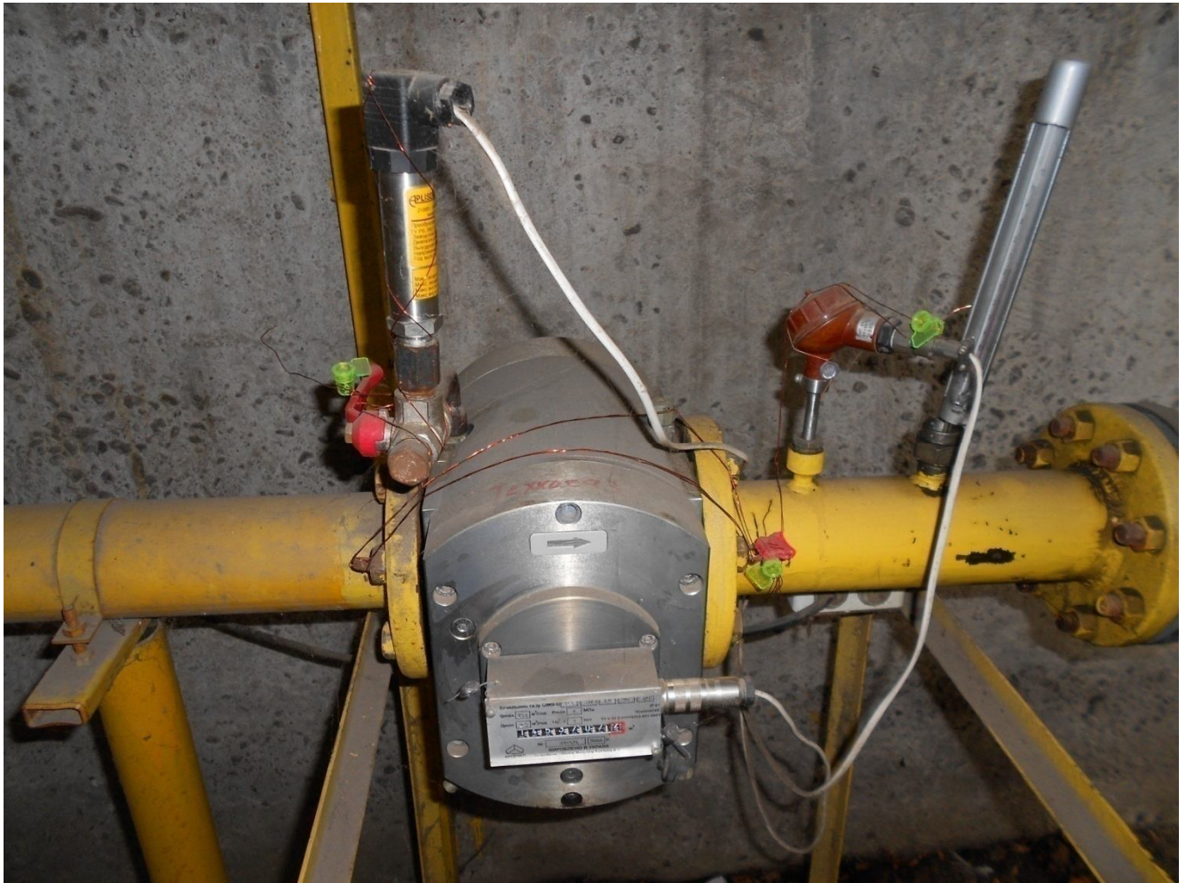
Рис. 3.39. Діючий вузол обліку природного газу на базі роторного лічильника
