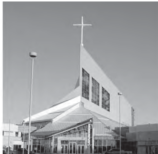
Рис. 7. Холл Сара, Глорія Люкс. Собор Святої Родини, Саскатун – панелі з художнього скла з кольоровими батареями PV [джерело: https://greenbuildingelements.com/2013/08/09/stained-glass-windows-capture-solar-energy/ ]
