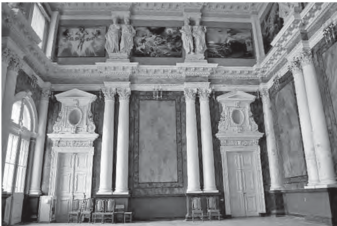
Лл. 3. У 2016 році спеціалісти кафедри розпочали реставраційні роботи з повернення автентичного вигляду актовій зали головного будинку Львівської політехніки. Під час робіт зняли пізніші однотонні пофарбування стін і декоративні елементи та реставрували автентичне пофарбування з 1877 р. "під мрамур". На фото процес розчищення стін та колон на західній та північній стінах зали
