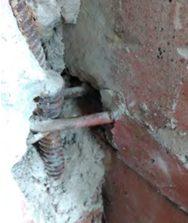
Рис. 9. На арматурні випуски у стику колони одягнуто U-подібні арматурні елементи для з'єднання із закладними деталями стінових панелей
