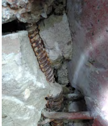
Рис. 10. U-подібні арматурні елементи з'єднання стінових панелей з колонами відгинають арматуру стику за рахунок вертикальних переміщень панелей
