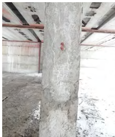
Рис. 16. Відшарування бетону у нішах стиків середніх колон спостерігаються у меншій кількості випадків
