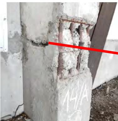
Рис. 6. Арматурні випуски у нішах колон крайнього ряду вигнуто у напрямку до внутрішньої грані колон
