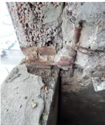
Рис. 15. Арматурні стрижні кріплення стінових панелей приварені до арматури стику кутових колон
