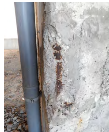
Рис. 16. Відшарування бетону у нішах стиків середніх колон спостерігаються у меншій кількості випадків
