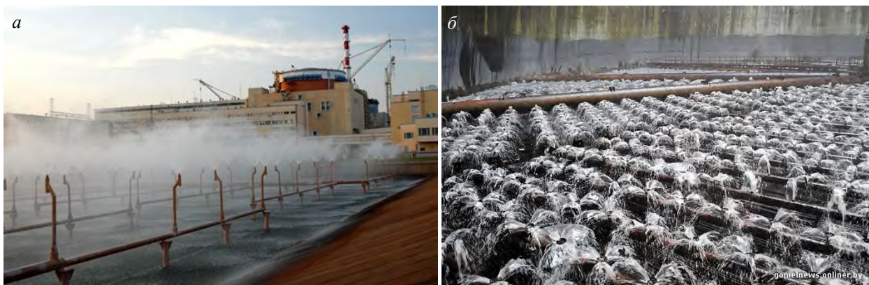
Рис. 6. Споруди для охолодження циркуляційної води в АЕС і ТЕС: а – бризкальний басейн на Ростовській АЕС (Росія, світлинку взято з сайта: http://www.atomic-energy.ru/news/2016/10/20/69770 ); б – РТ з соплами-розпилювачами в градирні Гомельської ТЕЦ-2 (Білорусь, світлинку взято з сайта: https://gomelnews.onliner.by/2013/08/01/sveta-i-tepla )
