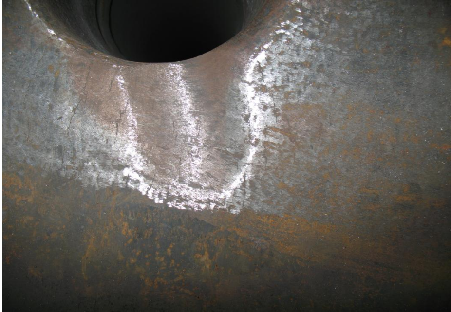
Рис. 3.67-а. Типові вибірки в околі отворів барабана котлоагрегату системи №18/ТП-100 конкретного блоку Бурштинської ТЕС, виконані за рекомендаціями роботи
