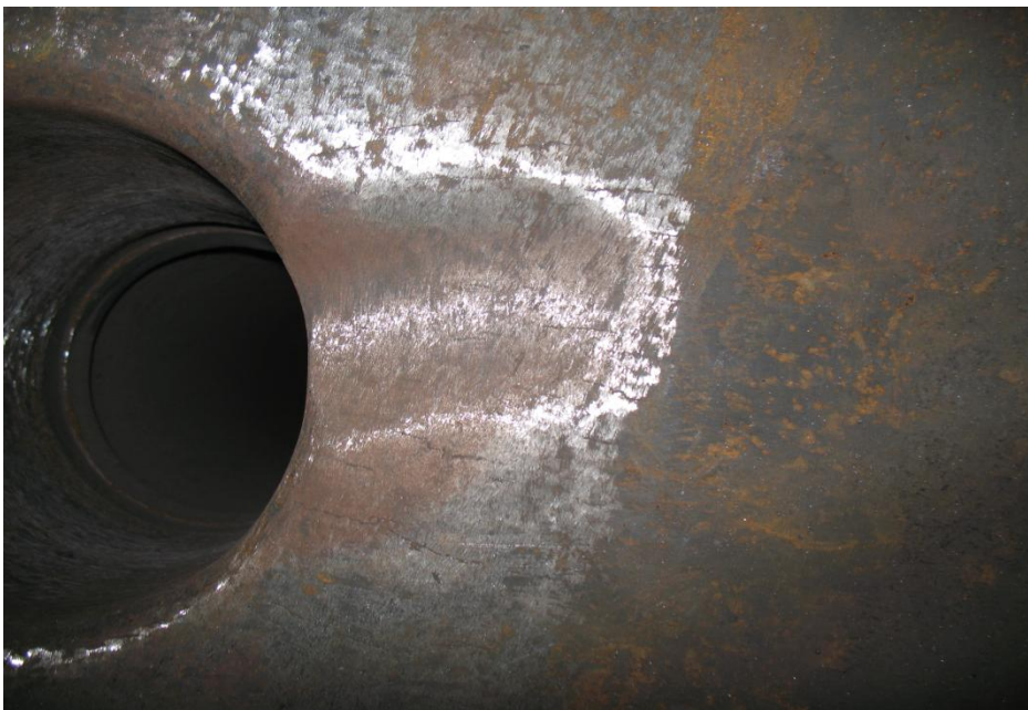
Рис. 3.67-б. Типові вибірки в околі отворів барабана котлоагрегату системи №18/ТП-100 конкретного блоку Бурштинської ТЕС, виконані за рекомендаціями роботи
