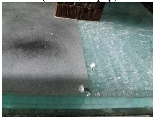
ПСБ-4.2, зруйновані всі шари (вигляд зверху)
