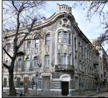
Прибутковий будинок, арх. М.Г. Рейнгерц, 1910 р.
