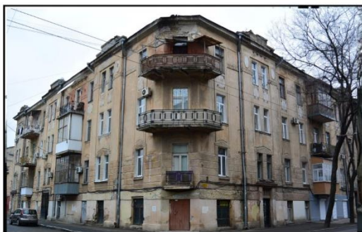
Прибутковий будинок М. М. Маркова, арх. Л.М. Чернігов, 1912 р.
