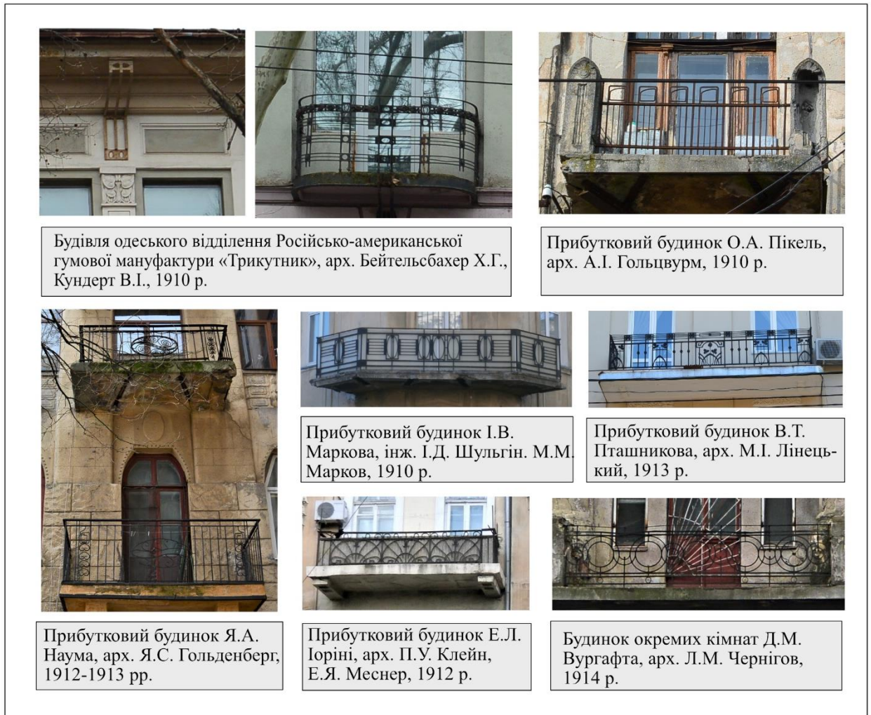
Рис. 3.3.2 Металевий декор на фасадах будівель пізнього модерну Одеси.
