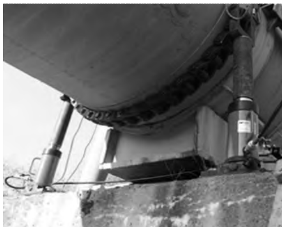
Рис. 2. Мобільний підймальний пристрій під час ремонту опорних вузлів МГ
