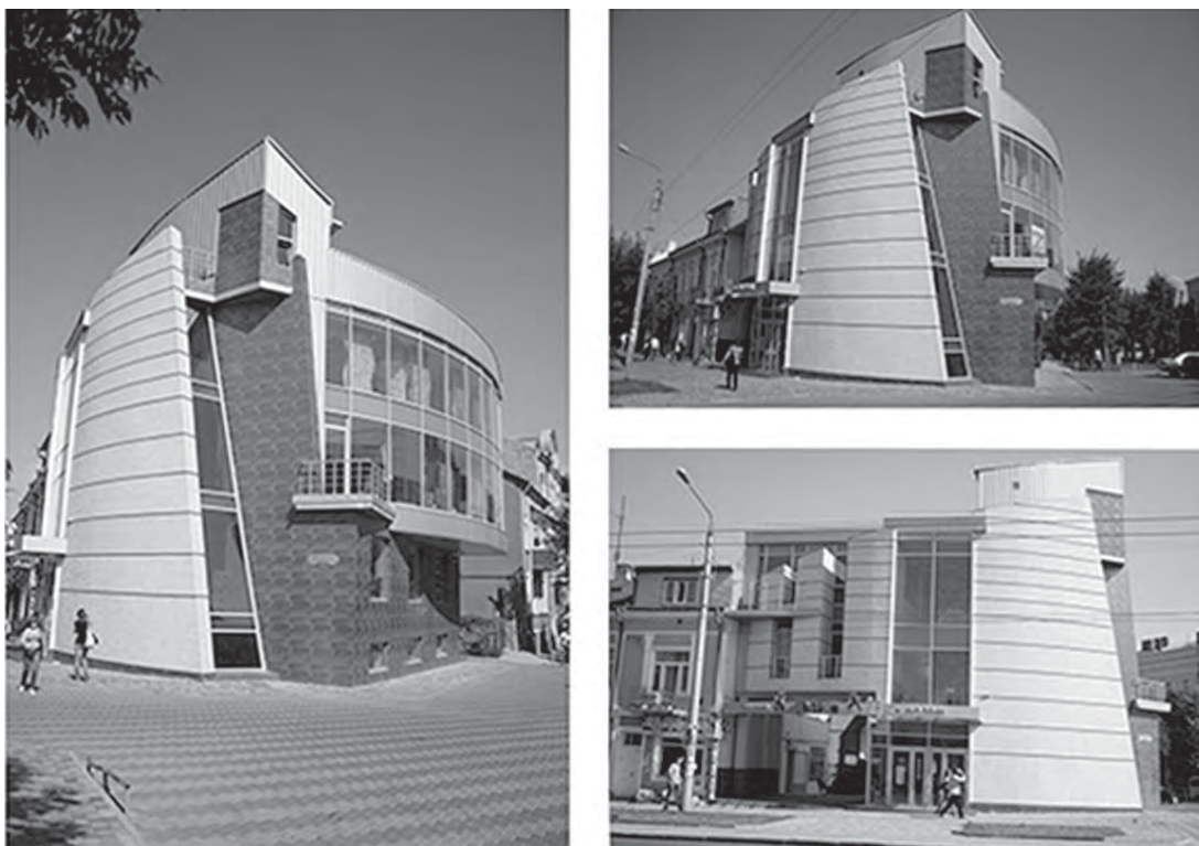
Рис. 2. Торговий центр на вулиці Садовій у м. Чернівці. Архітектор О. Кордунян. Збудований у 2007 р. (фото з архіву архітектора В. Мецзякова)
