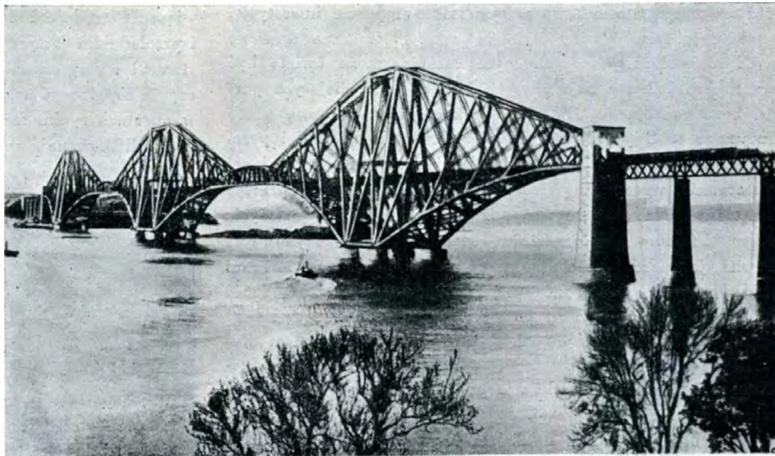
Widok ogólny mostu kolejowego na rzece Forth w Szkocji
