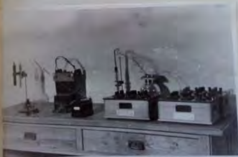
Установка для термического анализа двойных окисных смесей.
