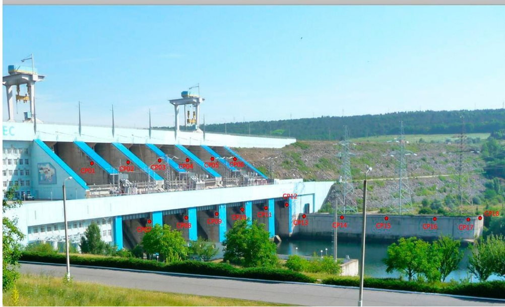
Рис. 4.23 Додаткові СР пункти спостереження для тахеометра встановленого в точці R1
