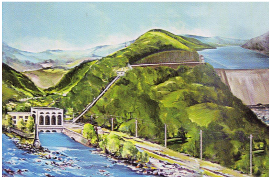
Рис. 4.13 Схематичний малюнок принципу роботи Теремле-Ріцької ГЕС
