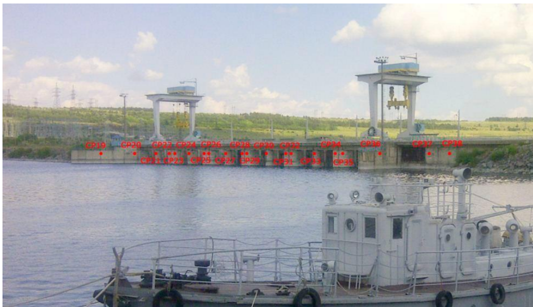
Рис. 4.14 Додаткові СР пункти спостереження для тахеометра встановленого в точці R2
