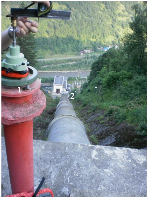
Рис. 4.16 Пункт спостереження 1. Установлення пристрою для вимірювання висоти антени
