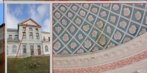
Зруйновано ліпний декор на портику тильного фасаду
