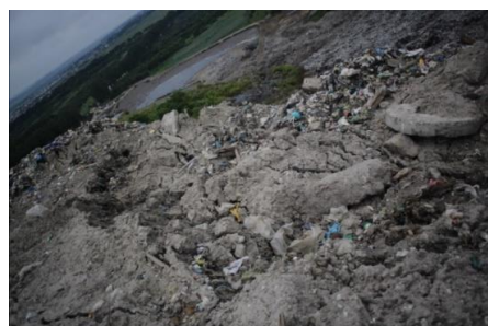
Рис. 4.10. Тріщина в північно-східній частині полігону ТПВ 28.06.2016 р.
