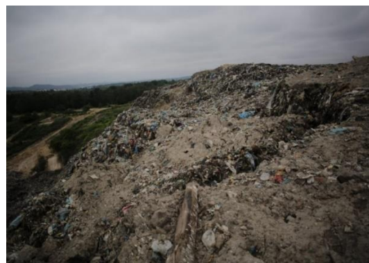
Рис. 4.8. Тріщина в південній частині полігону ТПВ 28.06.2016 р.
