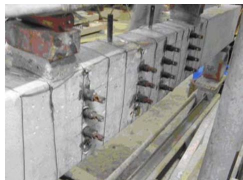
Рис. 1. Підготовка балки перед її підсиленням
