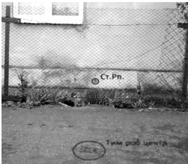
Рис. 1. “Закриття” стінового репера облицювальною плиткою та бруківкою робочого центра полігонометричного пункта
