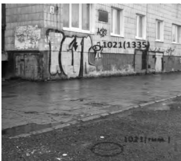
Рис. 2. “Закриття” робочого центра полігонометричного пункта бруківкою
