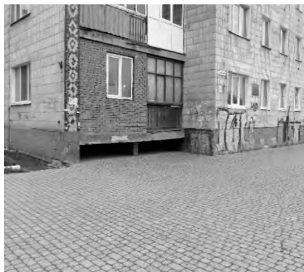
Рис. 2. “Закриття” робочого центра полігонометричного пункта бруківкою
