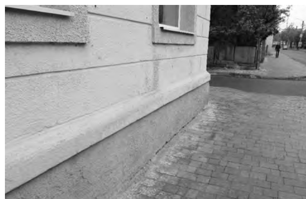
Рис. 4. “Закриття” стінового репера штукатуркою
