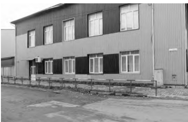
Рис. 3. Профільованим стіновим листом “закриті” стінові репери 2 і 3 полігонометричного пункта
