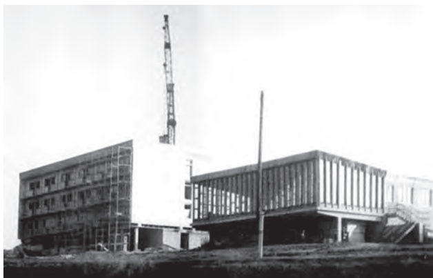
Завершується будівництво основних об’єктів бази навчального геодезичного полігона у м. Бережани. 1973 р.
