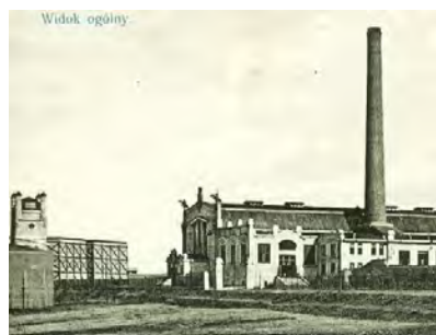
Електростанція на Персенківці (тепер Львівська ТЕЦ-1) і електричні мережі змінного струму у Львові (Фото 1908 і 1911 рр.)
