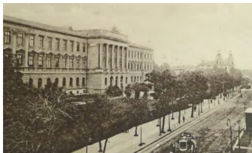
Трансформаторна підстанція навпроти головного корпусу Львівської політехніки
