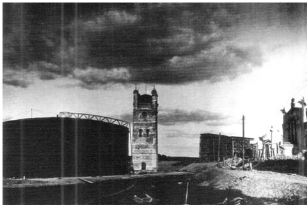
Рис.5 Мазутні резервуари та водонапірна башта електростанції на Персенківці (на задньому плані градильні охолодження). Архівне фото.1908 р. [7]
