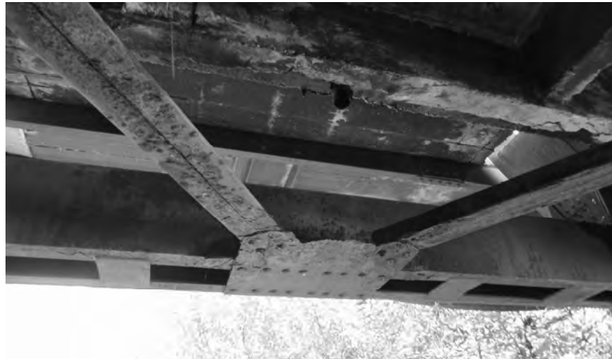
Рис. 2. Значна корозія балкової клітки і з'єднань
