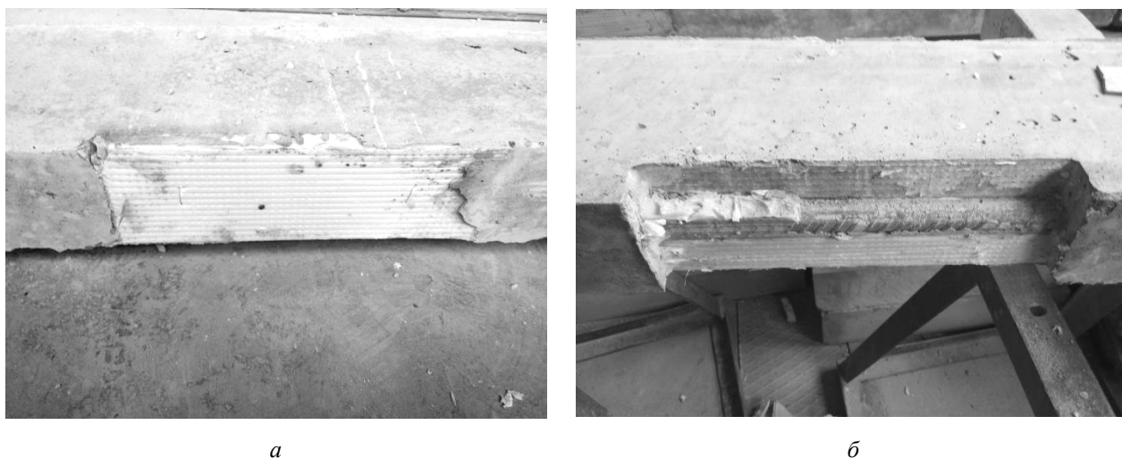
Рис. 2. Вигляд пінополістирольної вставки: а – перед демонтажем на балці; б – після демонтажу
