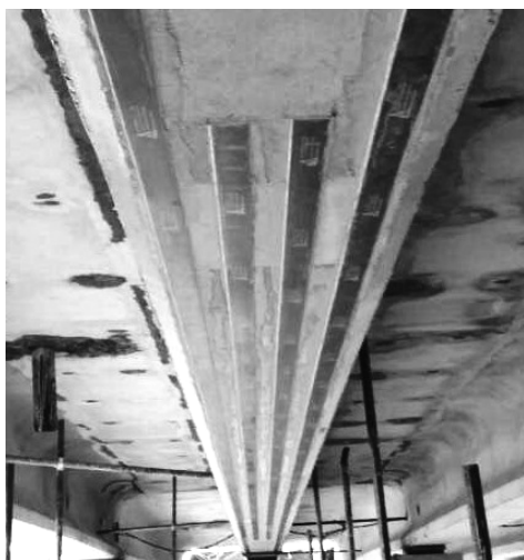
Рис. 4. Конструкція підсилення балок з використанням композитних матеріалів з вуглецевих волокон
