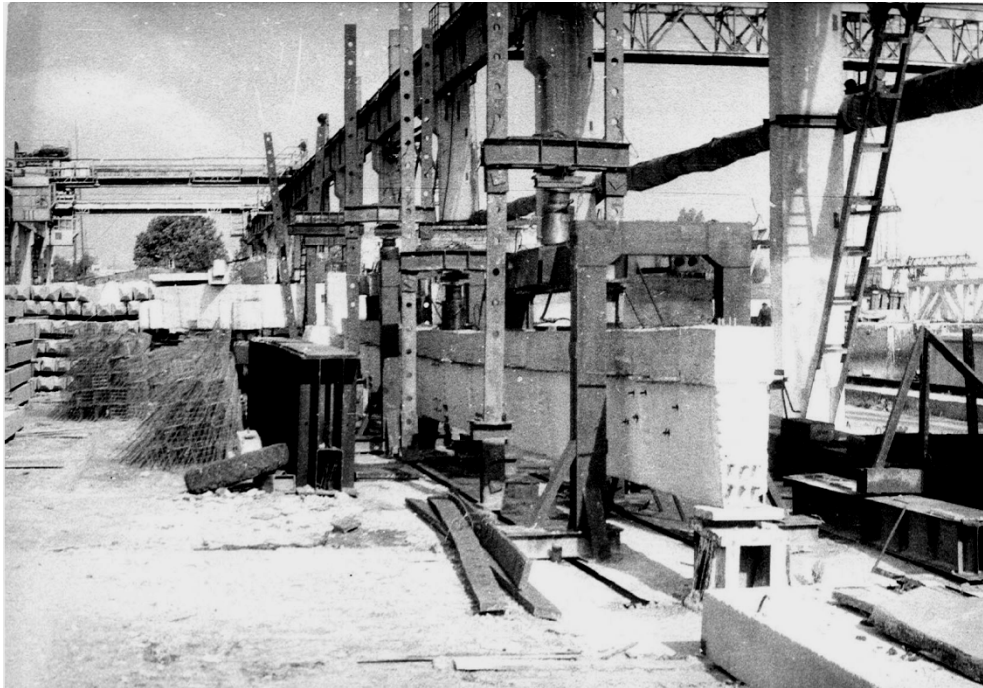
Рис. 4. Випробовування дослідної конструкції
