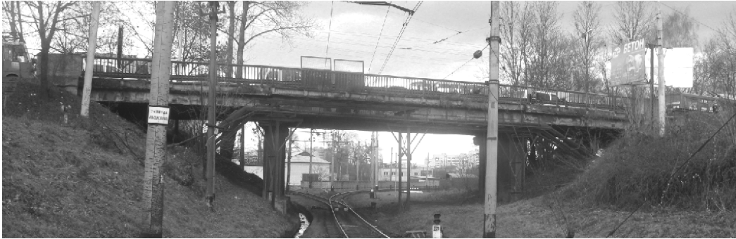
Рис. 1. Загальний вид шляхопроводу
