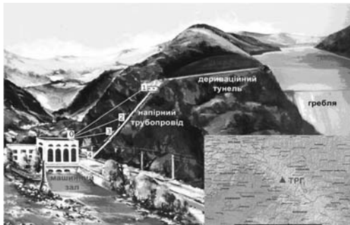
1, 2, 3, 4 – геодетичні пункти на анкерних опорах напірного трубопроводу 0 – станція спостереження
