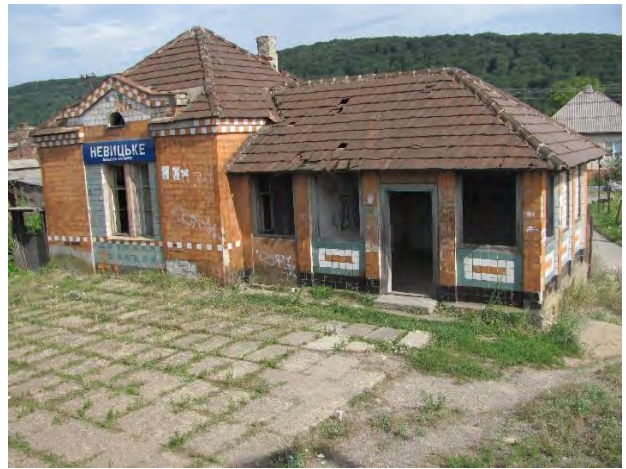
Рис. 16. Пасажирська будівля Нєвицькє
