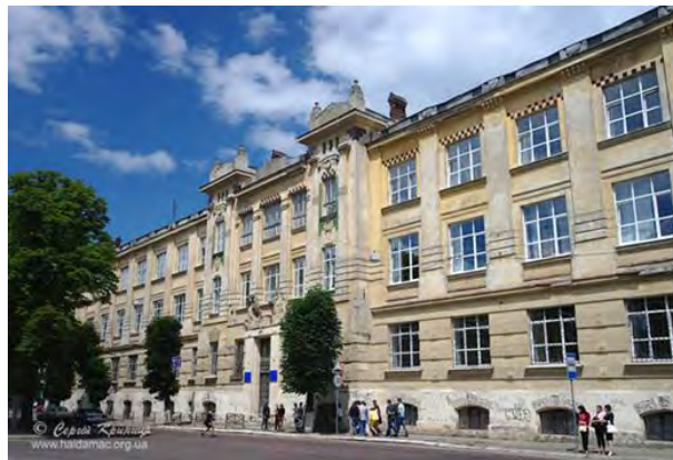
Рис. 18. Школа по вул. Снопківській, 47 (фото автора)
